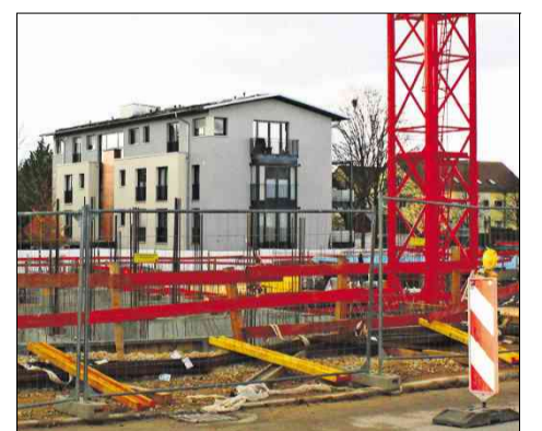
An der Karlshofstraße und Steckfeldstraße baut das Siedlungswerk. Foto: Jacqueline Fritsch
